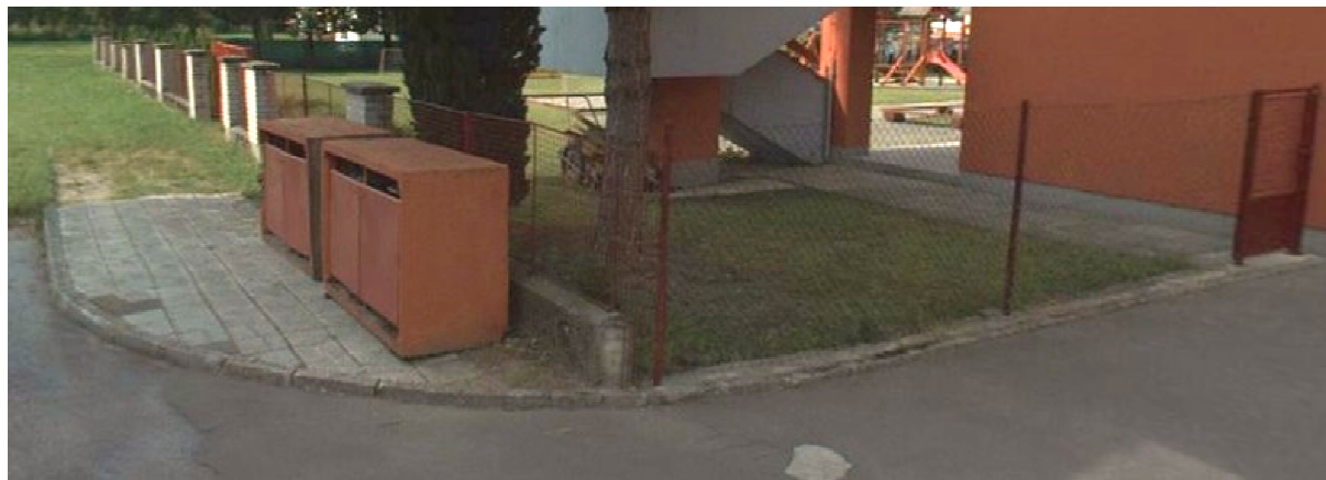
Stávající betonový přístřešek na popelnice, oplocení s podezdívkou s ocel. sloupky resp. zděnými pilířky
